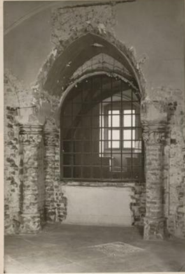
Feühcher Ost eingang von der Bürgerhalle aus gesehen Platte R. T. T. 9/14 u. 9/16.
